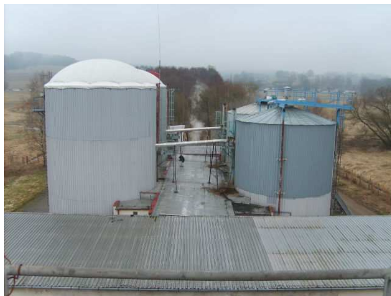
Obr. 6 Hlavní a sekundární fermentory
