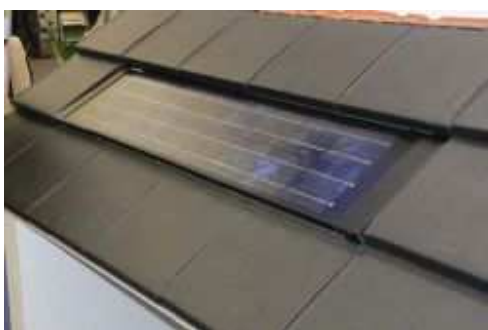
Obr.23 Fotovoltaické panely integrované do krytiny různým způsobem
