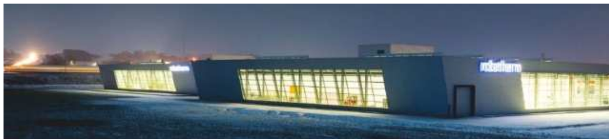
Nový výrobní závod firmy robatherm, Německo, Scheppach, ca 100 km za Mnichovem směrem na Stuttgart.
